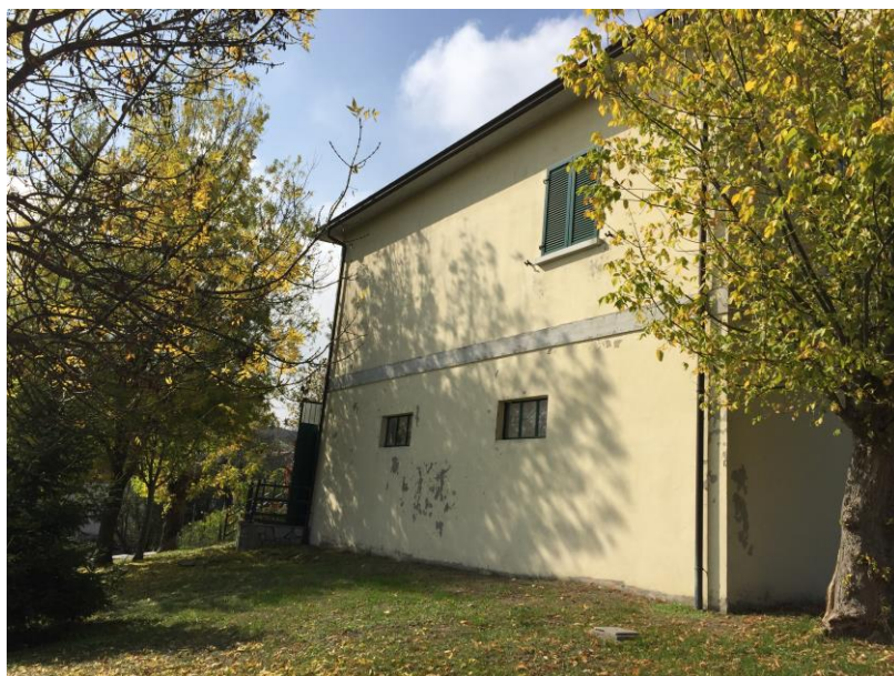
Foto 5 - Vista Est: da notare gli scrostamenti delle facciate che necessitano di intervento
